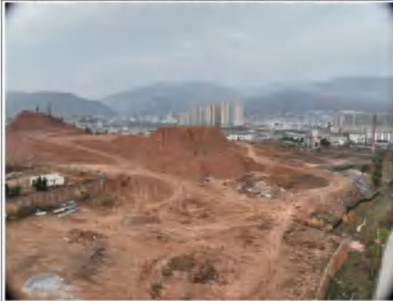
园区道路右边村庄及园区内部现状照片
