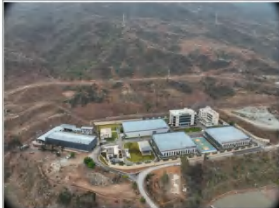
安定片区瀚辰、海固生物公司现状照片
