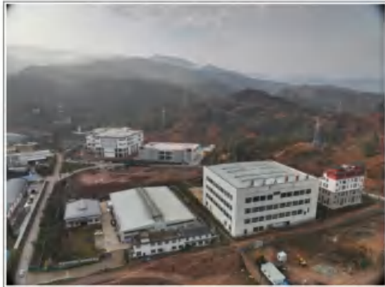
安定片区点苍、天上人间精制茶厂现状照片
