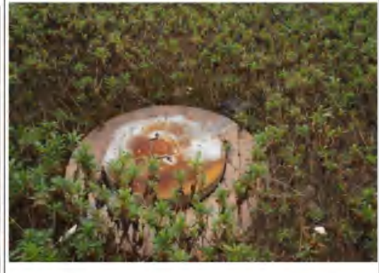
(6) 3#海固生物科技有限公司厂区内地下水监测井
